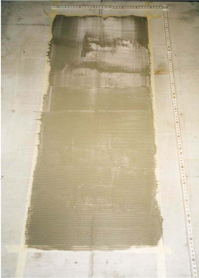
Bild 3: Klebstoffauftrag auf dem Betonuntergrund beidseitig der Arbeitsfuge
